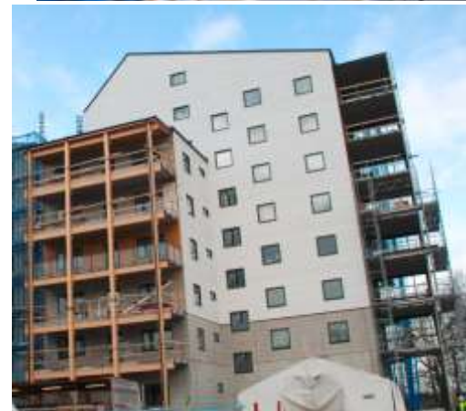
Kv. Vallen (Växjö), © Moelven Töreboda – 2015, 7 vån. med betongkärna
