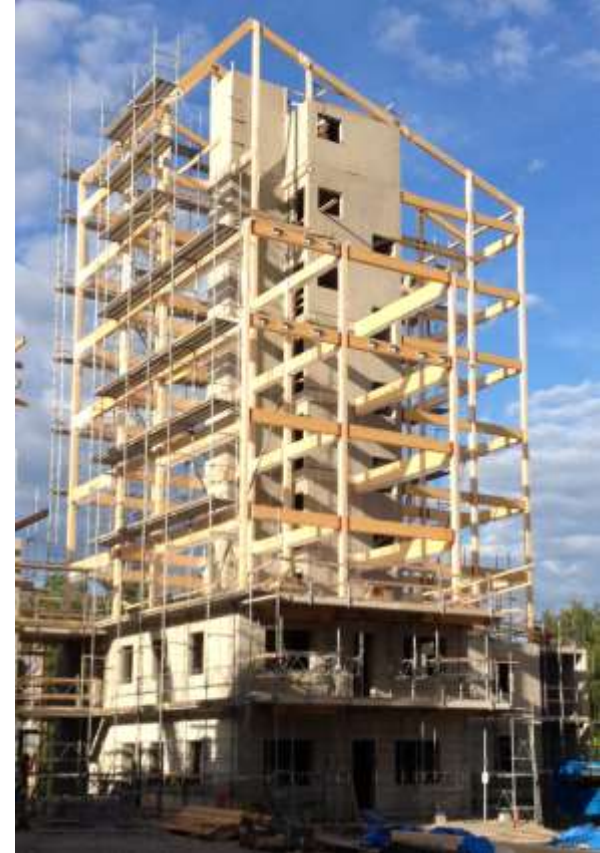
Kv. Vallen Växjö, Moelven, hybridkonstruktion pelar-balksystem i limträ med betongkärna
