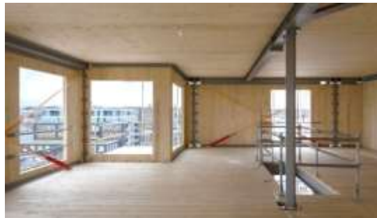
Wenlock Road London, Binderholz, hybridkonstruktion KLT med stål ramsystem och betongkärna
